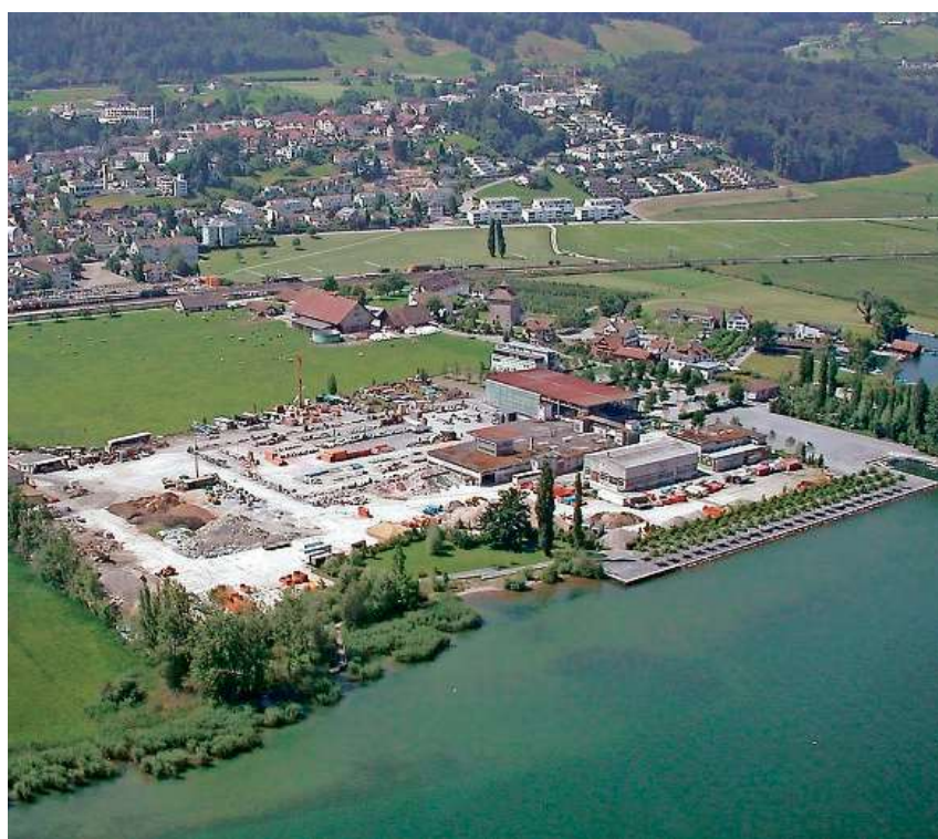
Steinfabrik-Areal muss renaturiert werden.
